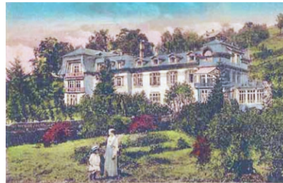
Krankenhaus Langnau, Baujahr 1898
